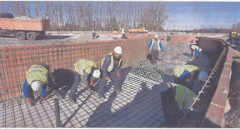
Le chantier n'a pour l'instant pris aucun retard. Photo Le DU/Patrick ROUX
